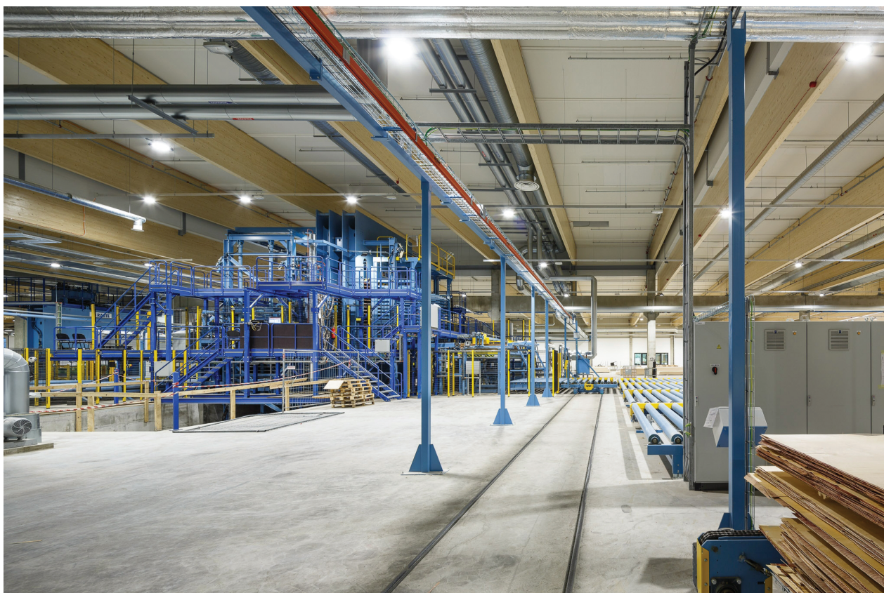
Рисунок 4. Здание Metsä Wood перекрытое с применением КДК
