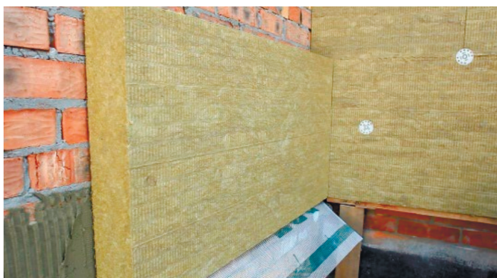
Рисунок 1. Утепление фасада минераловатными плитами
