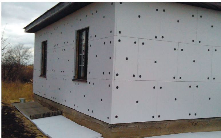
Рисунок 2. Утепление фасада ЭППС
