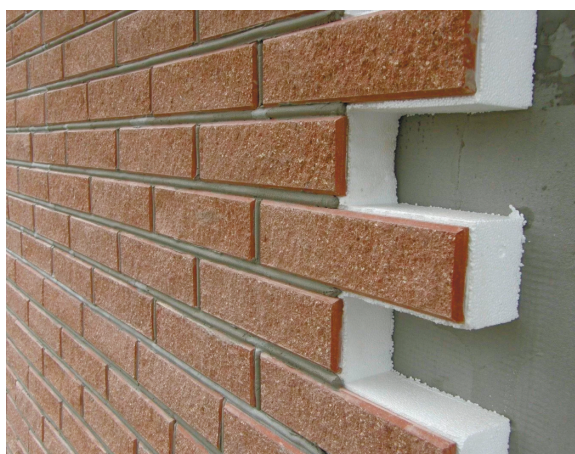
Рисунок 3. Утепление фасада плитами вспененного пеноуретана с отделкой
