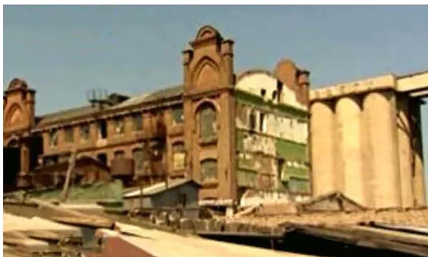
Рисунок 2. Мельница купца Зарывного до реконструкции
