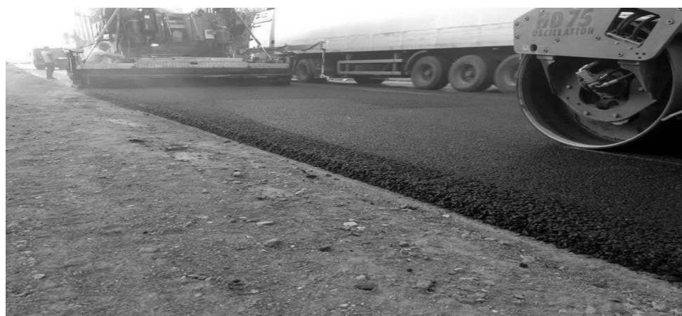
Рисунок 1 – Укладка щебеночно – мастичного асфальтобетона
