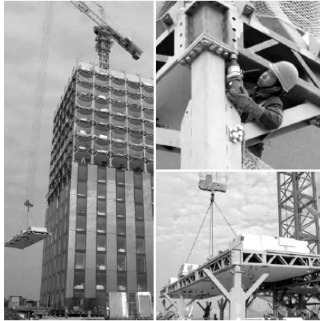
Рисунок 1 – Монтаж строительных конструкций отеля T30 в Китае
