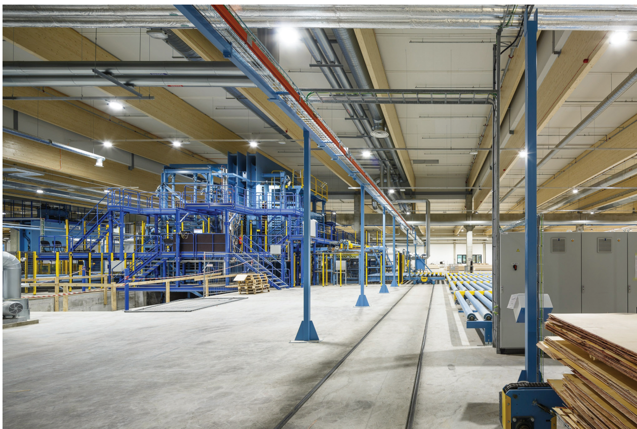
Рисунок 4. Здание Metsä Wood перекрытое с применением КДК
