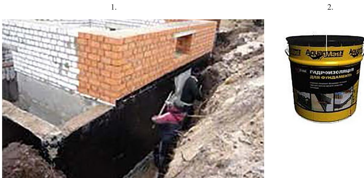
1 – нанесение гидроизоляционного материала на тело фундамента; 2 – битумная мастика
