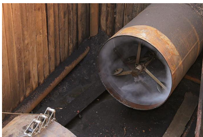
Рисунок 2 – Гидроочистка внутренней поверхности газопровода
