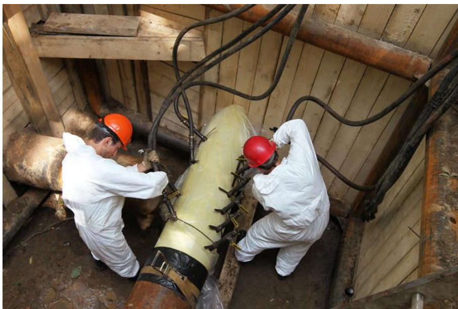
Рисунок 1 – Закрепление полимерного рукава на внутренней поверхности газопровода при помощи повышенного давления и температуры
