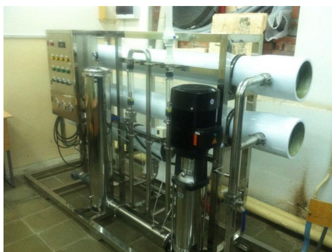
Рисунок 1 – Установка обратного осмоса с пятью мембранами FROTEC RO 5000 – 8040
