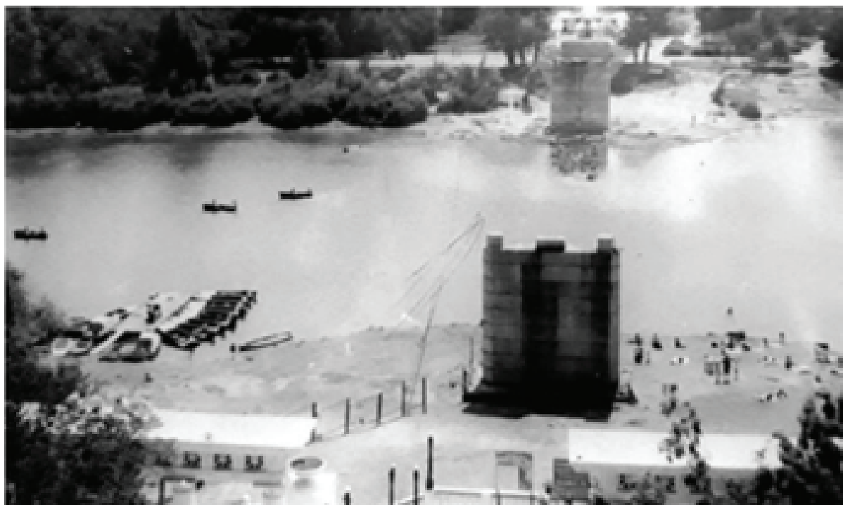
Рисунок 1 – Реальная фотография строительства
